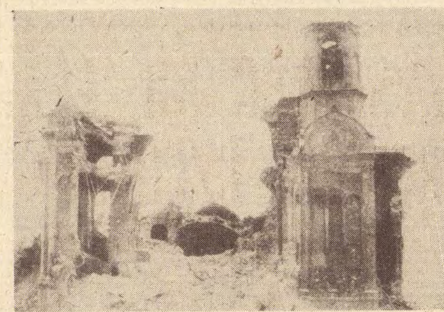
Widok po zburzeniu
